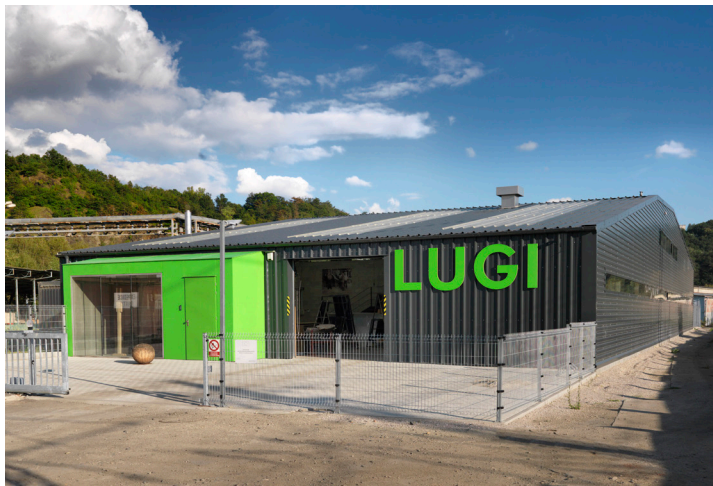
Nová budova společnosti LUGI, s.r.o.
